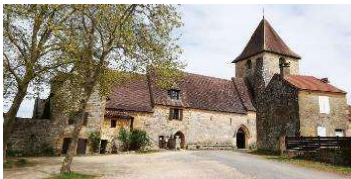
Le bâtiment principal
